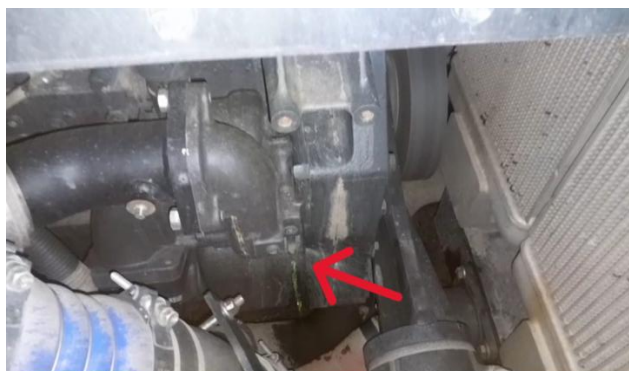
Gambar 2. kebocoran coolant melalui weep hole pada water pump D375-6R
