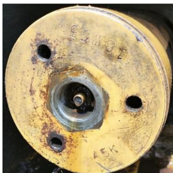
Gambar 2. Foto kebocoran gas valve pada brake accumulator (Sumber: dokumentasi pribadi)
